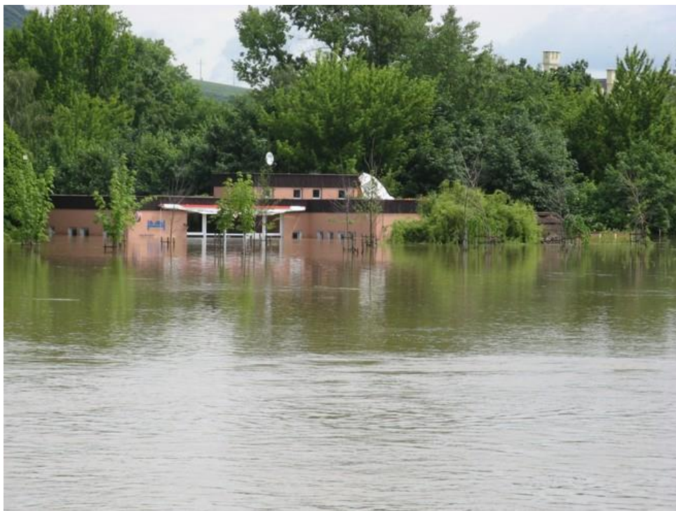
Obrázek 15: Povodně 2013 - pohled na saunu
